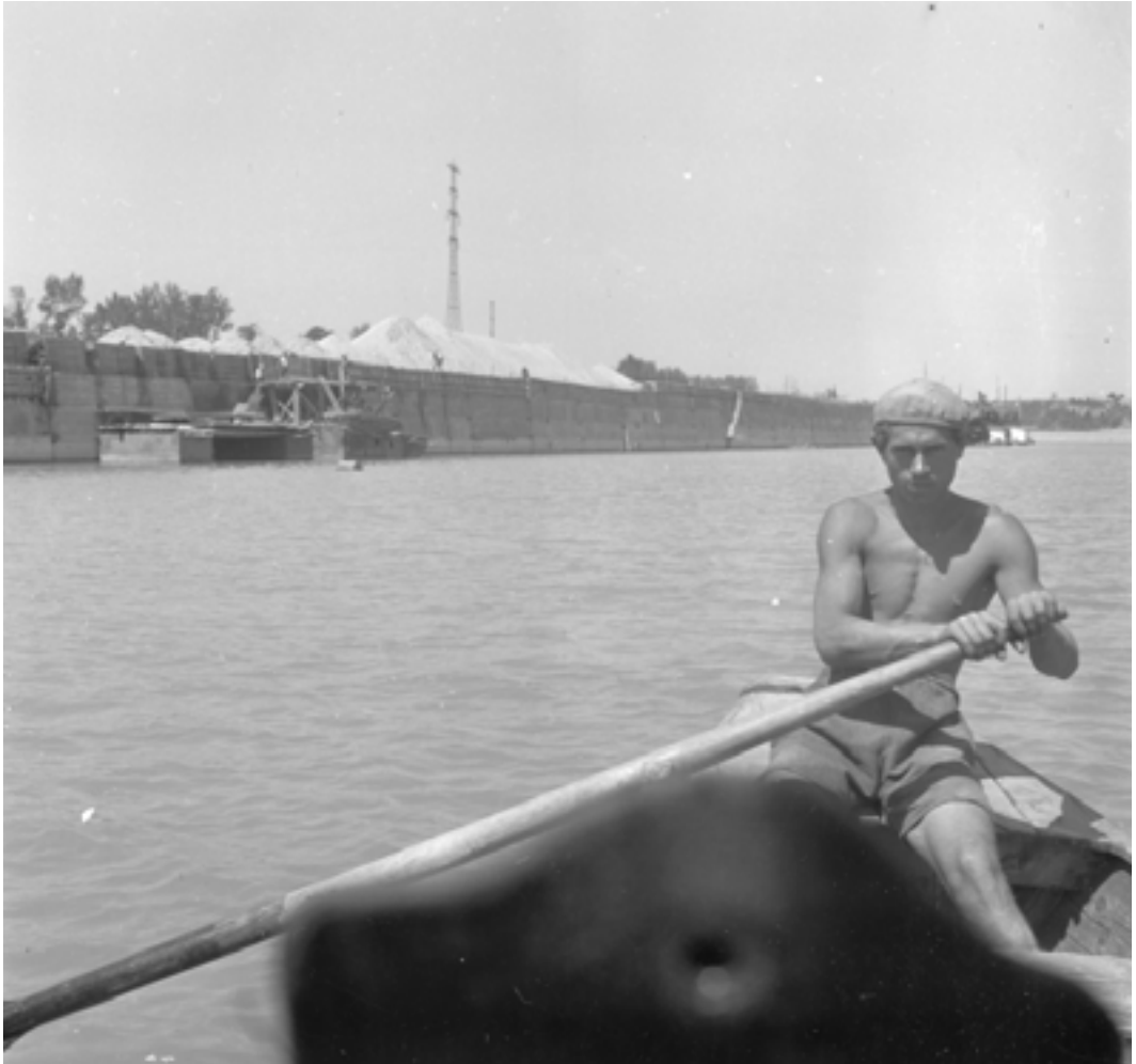
A sztálinvárosi kikötő építése
