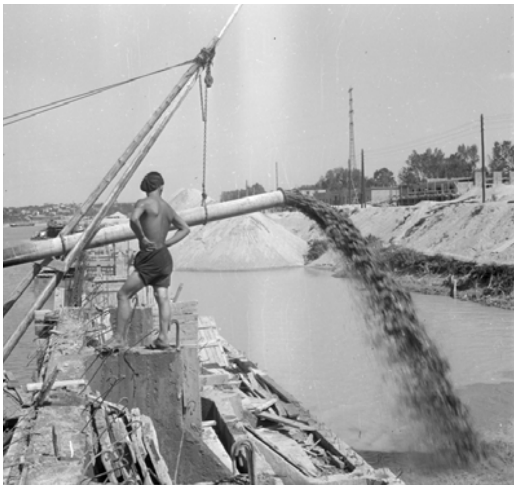
A szálinvárosi kikötő építése
