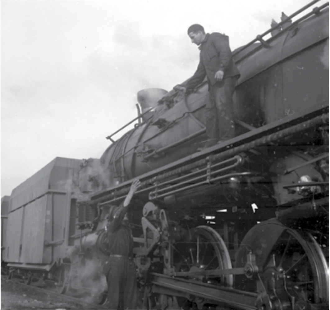
A sztálinvárosi kikötő építése, MÁV 411.407 pályaszámú gőzmozdony
