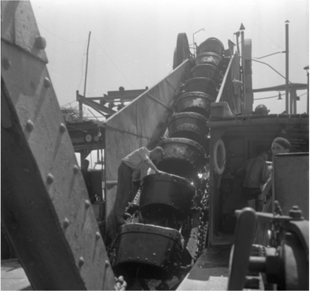
A sztálinvárosi kikötő építése, kotróhajó
