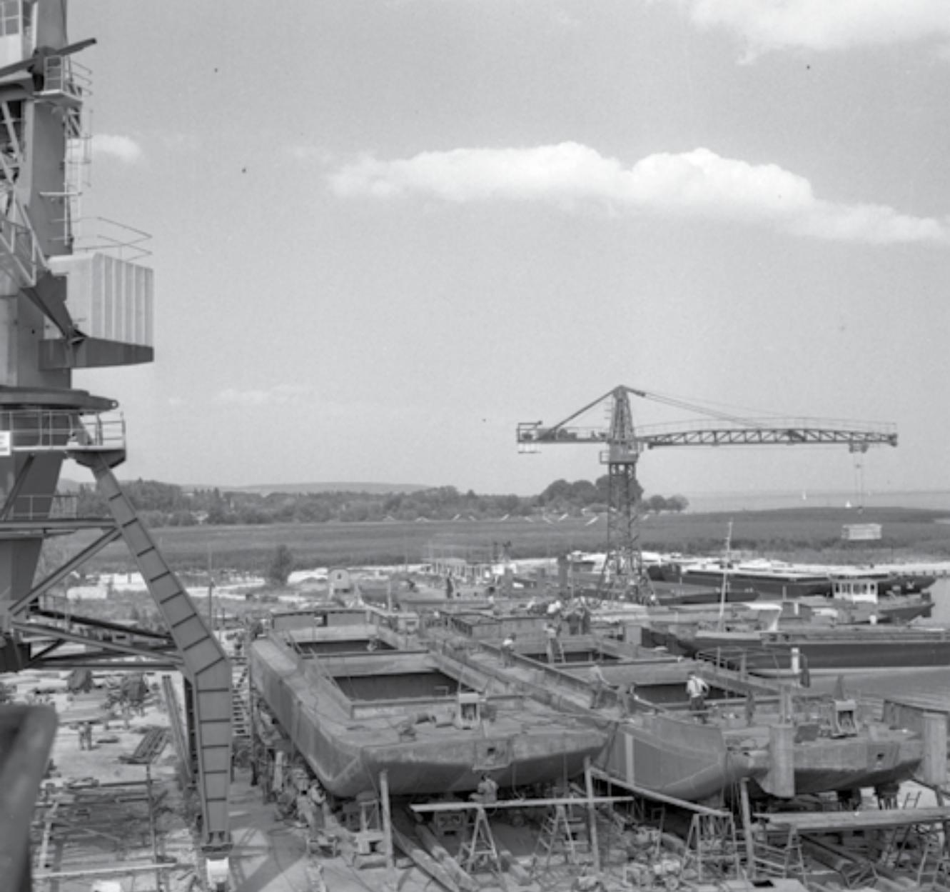
4. képmelléklet: Egyiptomi megrendelésre készülő áruszállító uszályok (EAK tolóegységek) az MHD balatonfüredi hajógyárában. Háttérben két épülő ismeretlen balatoni kishajó (BHG halászhajó, mögötte feltehetően az ÓBUDA mini jégtörő). A felvétel az egyik hajógyári daru kezelőfülkéjéből készült*
