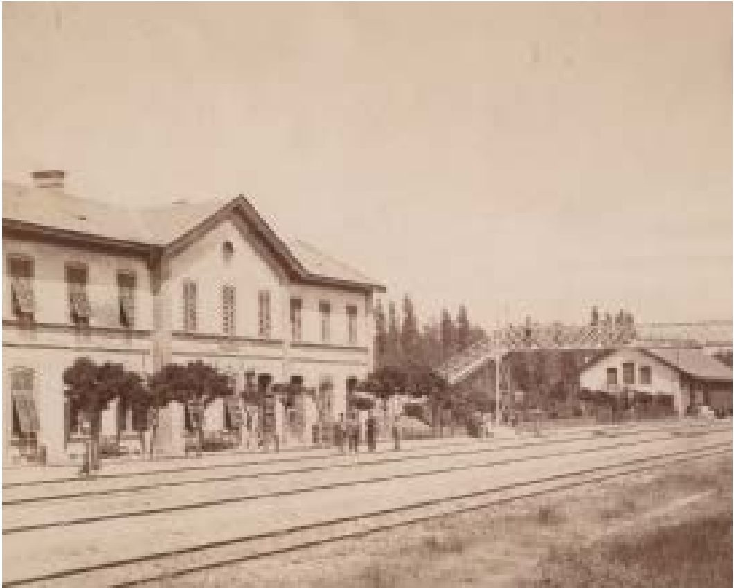
3. kép. Rákospalota-Újpest vasútállomás, MMKM TFGY 363
