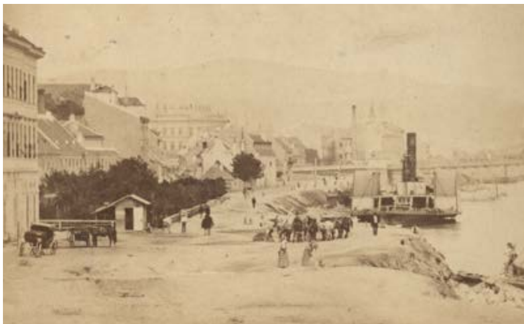
Kép D. – A mai Várkert előtti Sétatér és tabáni hajóállomás az 1860-as évek végén. A felvétel a Lyka-ház mellett készült (lásd KÉP2). Középen egy hajóvontató-fogat látható, tőle jobbra a DDSG JOHANN BAPTIST (1853) vontató gőzhajó, a kép sarkán pedig egy bögöshajó áll kikötve. A bögöshajó álló őrfája alapján valószínűleg a hajóvontatók épp végeztek a vontatással. Forrás: FSZEK Budapest Gyűjtemény, Képtár 080102.
