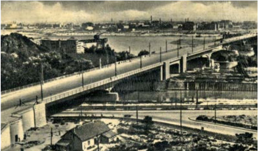
A Sztálin híd. Az óbudai oldalon teljes, onnan fél szélességben elkészítve. MMKM KPLGY 2017.503.1.
