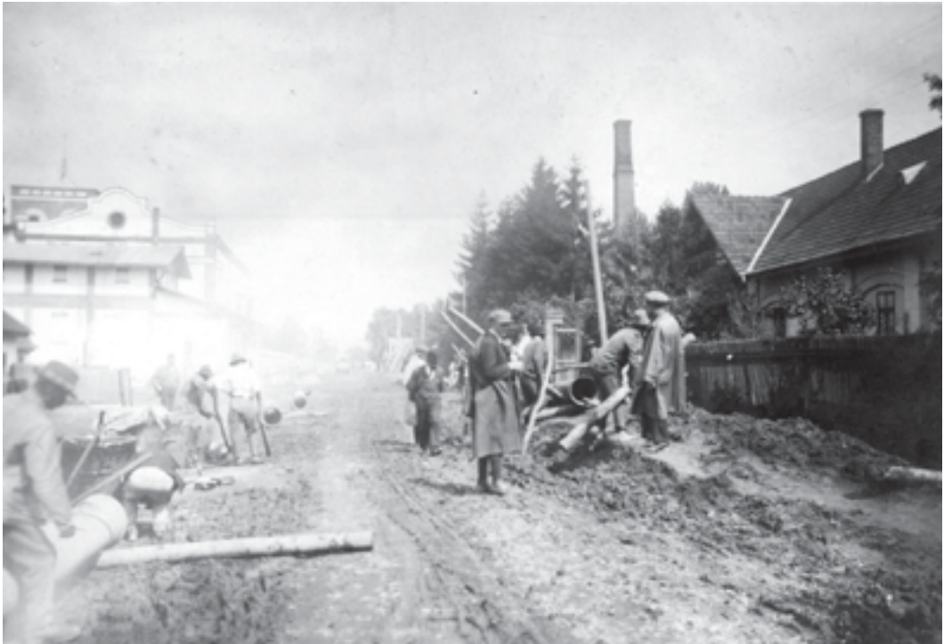
4. kép: Gázvezeték-építés a román megszállás alatt lévő Dicsőszentmártonban, 1919 (Magyar Olaj- és Gázipari Múzeum, Fk. 2010.1.1.)
