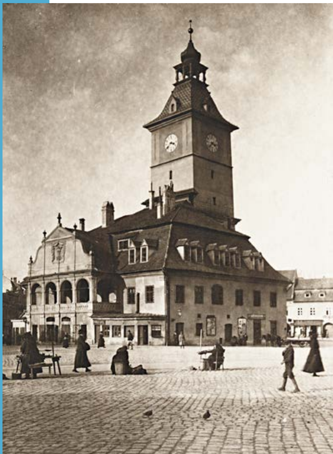
Brassóban az 1890-es években építették ki a vízvezetékét, ám a csatornahálózatra még várni kellett. Fortepan / Erky-Nagy Tibor
