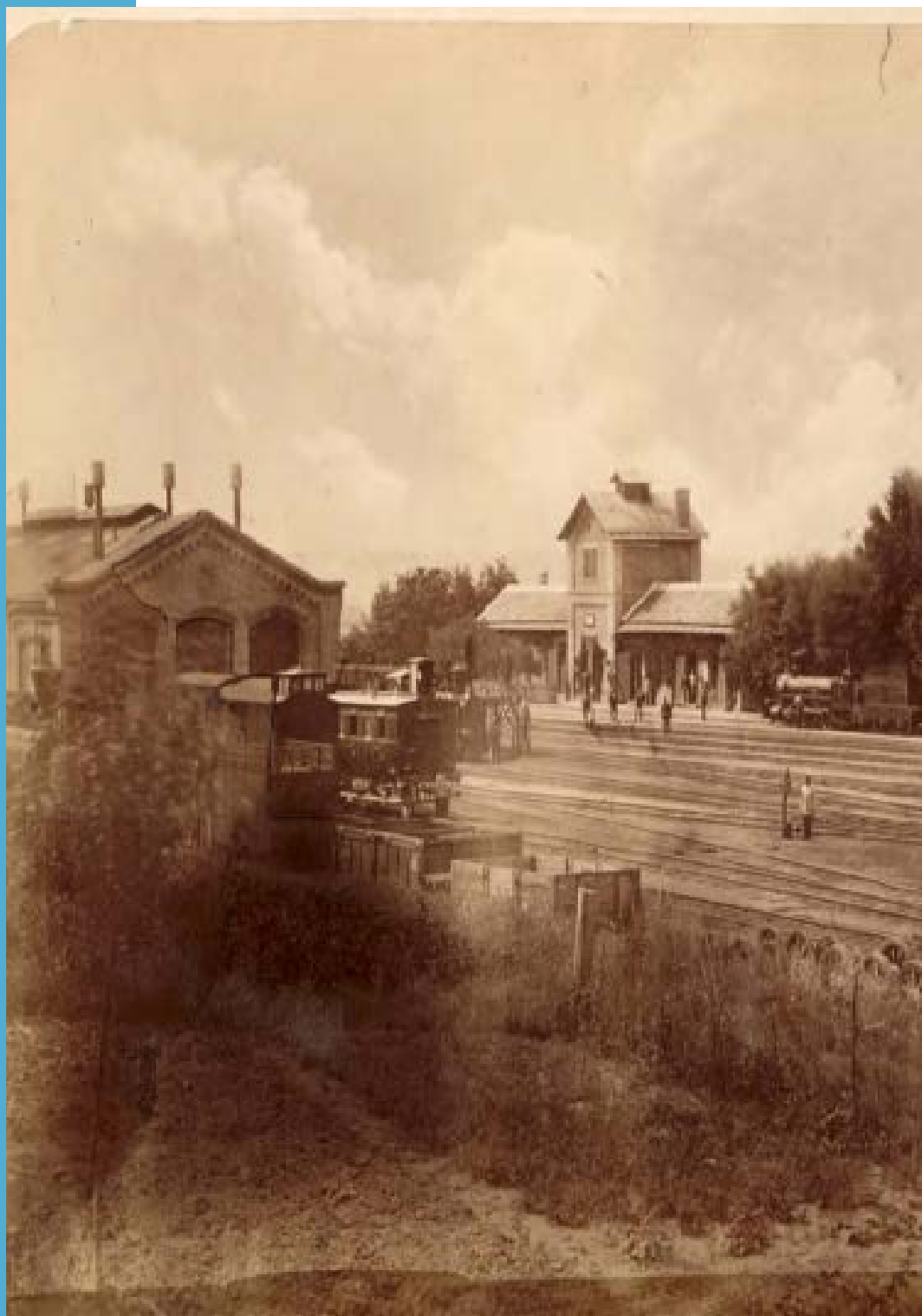
1. kép. Az úszögi pályaudvar látképe fűtőházzal és felvételi épülettel 1877-ben. Forrás: MMKM TFGY 2018.370.
