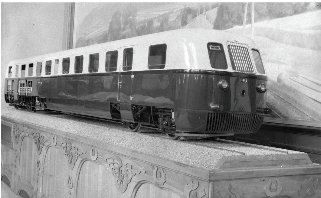
Az Árpád sínautóbusz gyártáskori, osztatlan ajtós változatának 1:5 modellje a M. Kir. Közlekedési Múzeumban. MMKM TEMGY 2020.10.1.II/004
