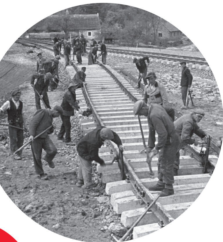
Vasúti szárnyvonal építése
