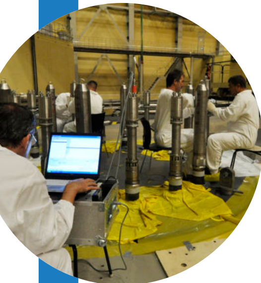
Kazetta-kilépőhőmérséklet mérőjének revíziója a pódiumon a paksi atomerőben Atomenergetikai Múzeum Archívum
