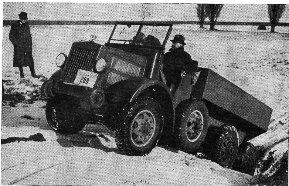
35. ábra. „Botond” típusú kísérleti terepjáró gépkocsi (1938)
