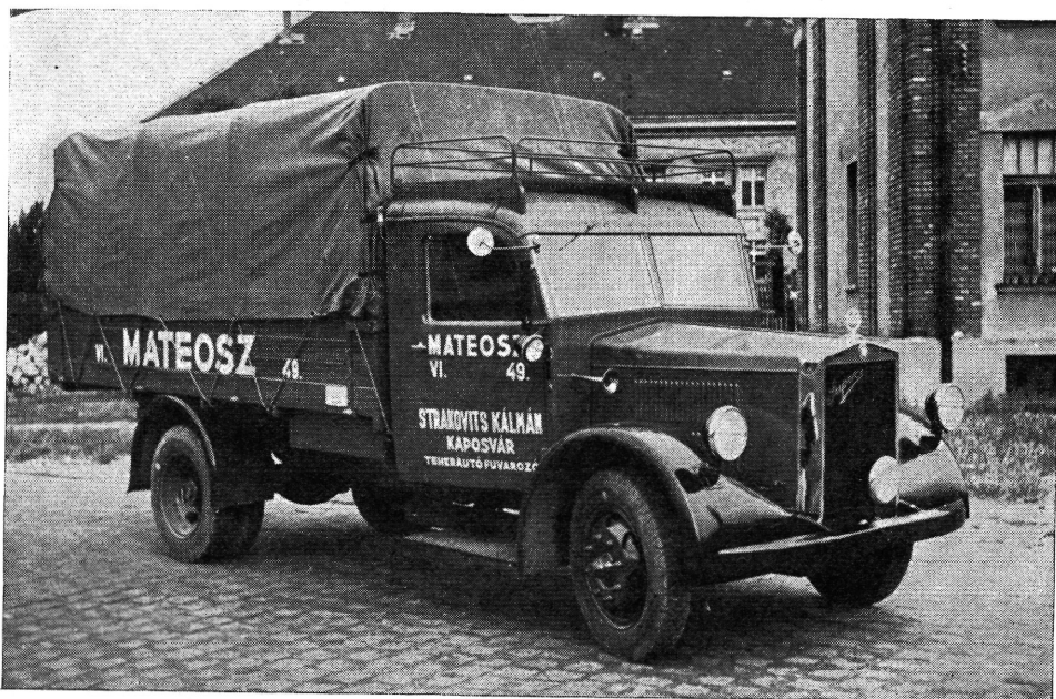
28. ábra. „Rába Super” típusú 2,5 tonnás gyorstehergépkocsi (1936)
