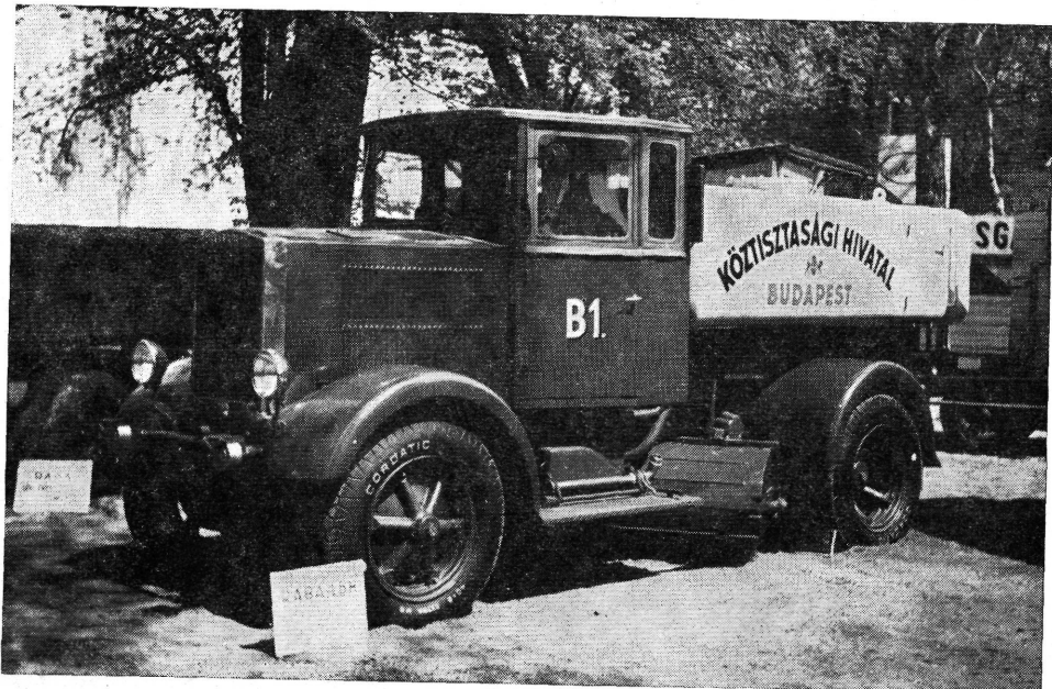
20. ábra. „Rába—Krupp L5H” típusú 4000 literes seprő-mosó gépkocsi
