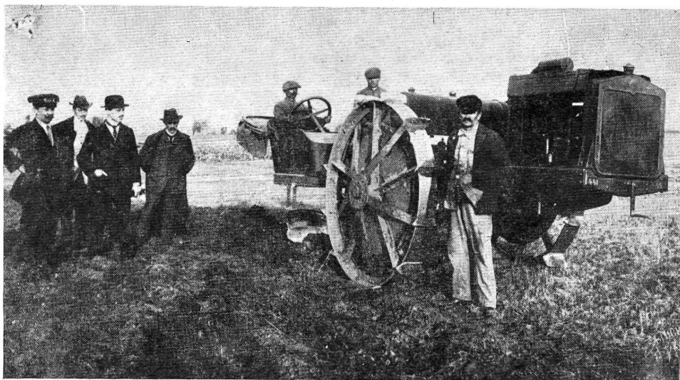
10. ábra. „Rába K II.” típusú motoreke szántáspróbája (1916)
