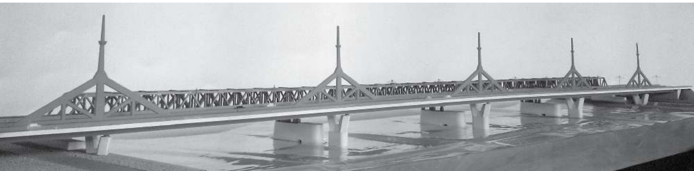
A jelenlegi hídszerkezet alternatív megoldása. A függesztőrudak rácsos merevítéssel. (1992)
