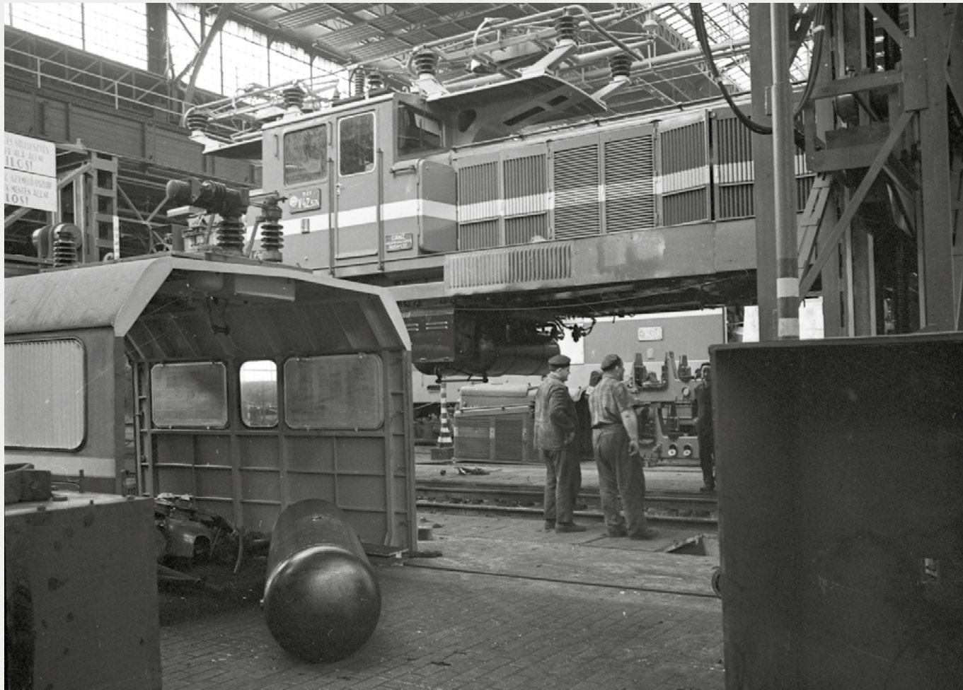
8. ábra - Az Eiffel csarnok javítás alatt álló villanymozdonyokkal 1976 körül. Az emelőn a V42 524-es Ward-Leonard rendszerű mozdony. (MMKM)
